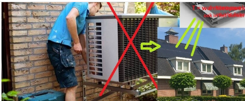
Op Rijkoverhd IedereenDoetWat.nl 'de' warmtepomp naar 'een' wp met PVT-zonpanelenbron
